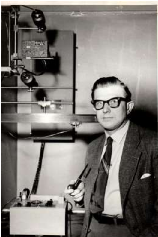
Kuva 2. Hans Blomberg ja väitöskirjatyönä konstruoitu magneettivuon mittausjärjestelmä 1953.
