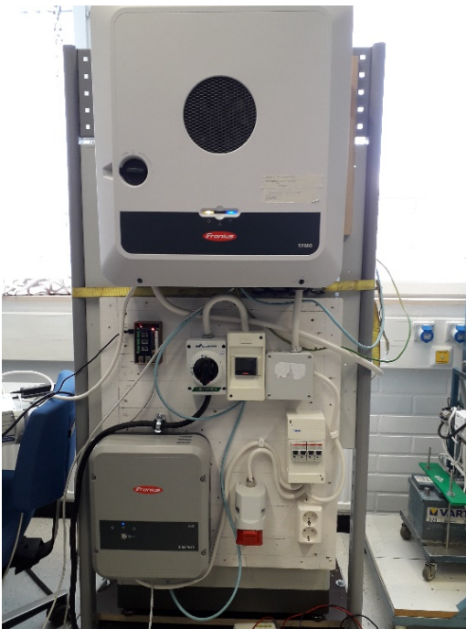
Kuva 1 Nanogrid laitteiston testausta
